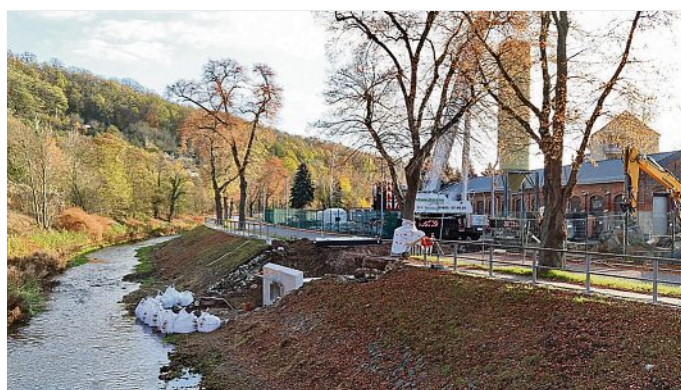
Errichtung des Auslaufbauwerkes mit Rückstauklappe.
