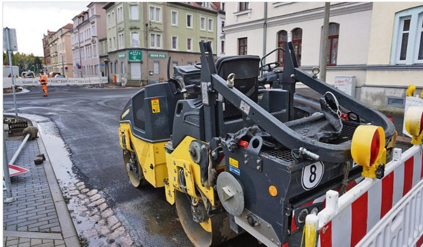
Tiefbauarbeiten in der Stadt Meissen.
