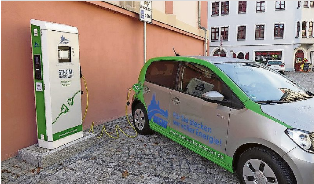
Ladestation an der Roten Schule.
