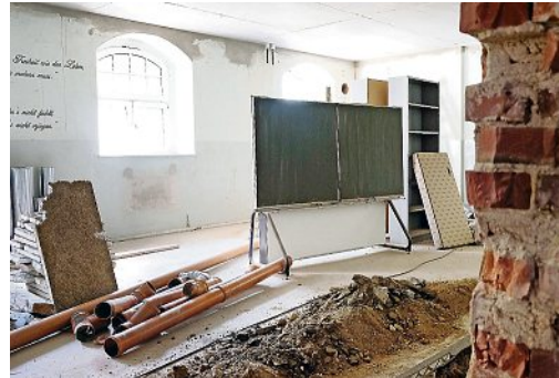
Eine Baustelle ist die Weinbergschule in diesem Schuljahr. Foto: C. Hübschmann
