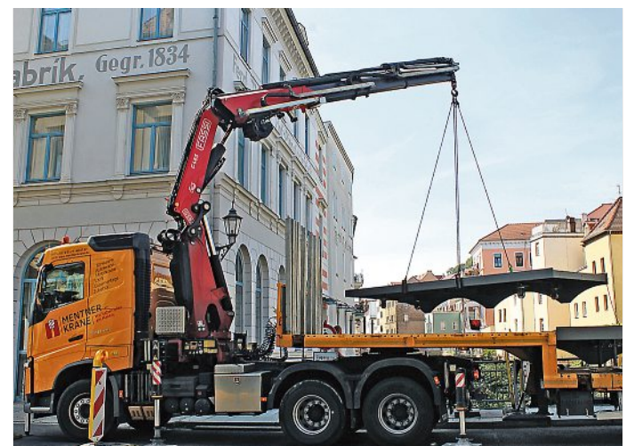
Zwei Tonnen wiegen die einzelnen Gehwegplatten. Foto: Stadt Meißen
