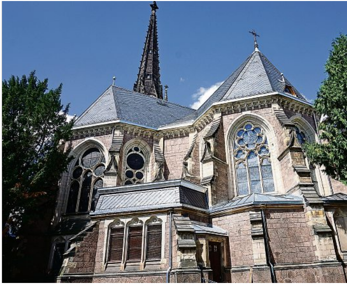
Das neugedeckte Dach
