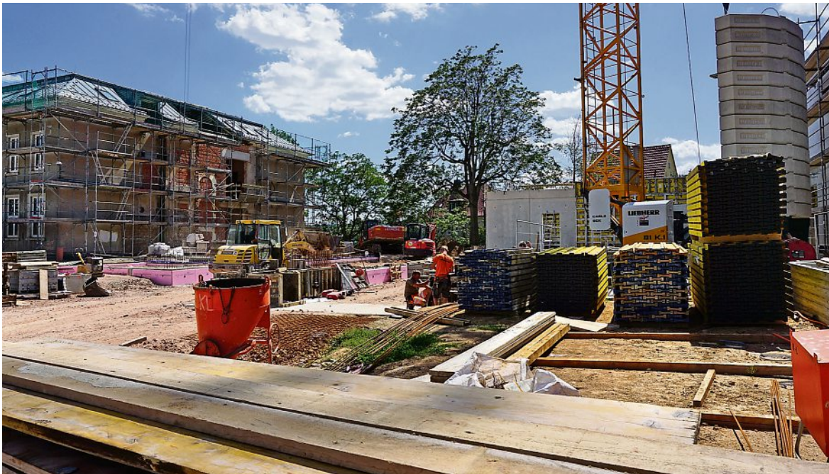
Blick auf die Baustelle an der Grundschule auf dem Questenberg.
