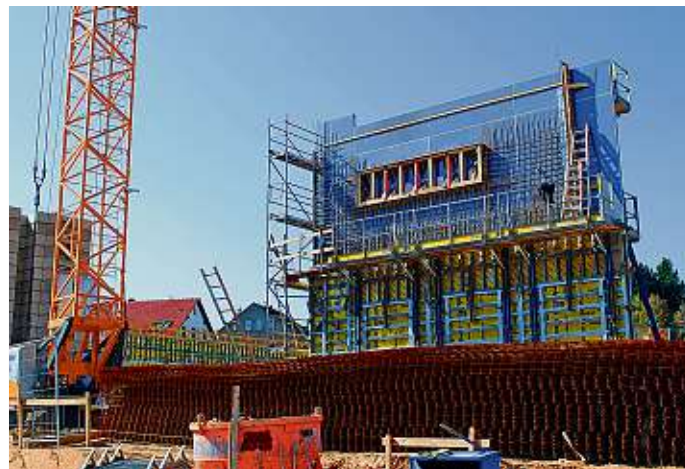
Das bis Höhe der Dachunterkante geschaltete Treppenhaus der neuen Turnhalle.
