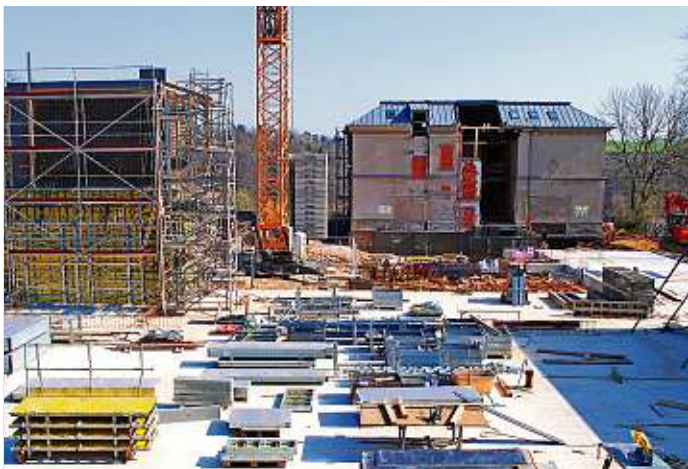
Blick auf die Baustelle der Questenberg-Grundschule vom Wasserweg. Fotos: Stadt Meissen
