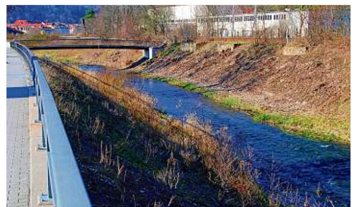
In diesen Abschnitt der Triebisch (Fußgängerbrücke in der Jaspisstraße) wird die Hochwasserentlastung des Gainitzbaches eingebunden.
