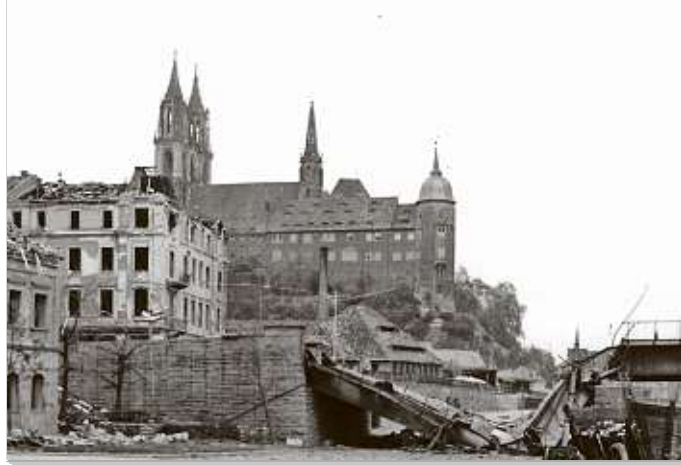
Am 26. April 1945 erfolgte gegen 17 Uhr die Sprengung der Elbbrücken.
