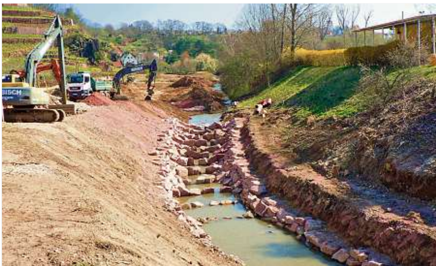
Die Riegel im Gewässerbett verringern die Fließgeschwindigkeit
