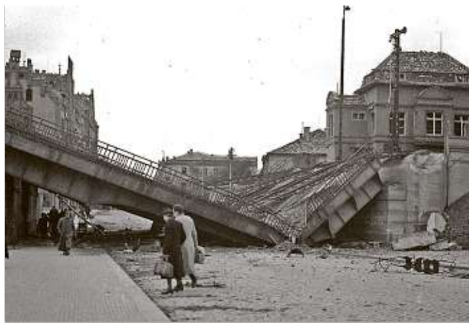
Zerstörte Eisenbahnüberführung an der Dresdner Straße.
