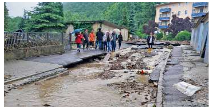
In den Straßen Am Kirchsteig und An der hohen Eifer hinterließ die Schlammlawine des Jahres 2014 besonders starke Schäden
