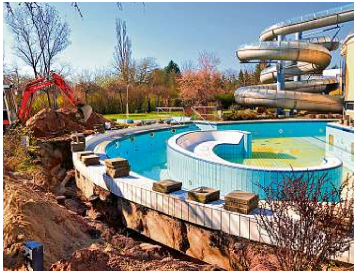
Erdarbeiten im Außenbereich
