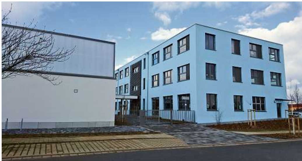
: Blick auf die 4. Grundschule vom Aritaring aus.
