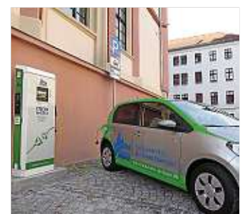
Die neue Stromtankstelle am Schulplatz. Foto: MSW
