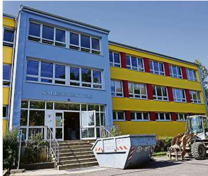
Sanierung über alle drei Etagen: der 3. Bauabschnitt an der Förderschule.
