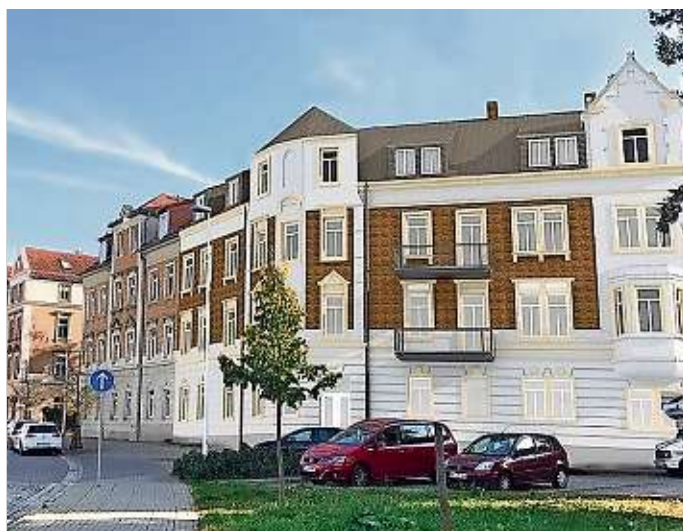
Momentan noch Baustelle, 2020 Realität: das sanierte Wohnobjekt Robert-Koch-Platz 2.
