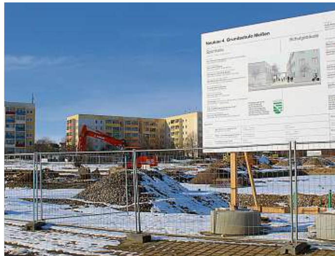
Die ersten Fundamente für die neue 4. Grundschule am Aritaring stehen bereits.
