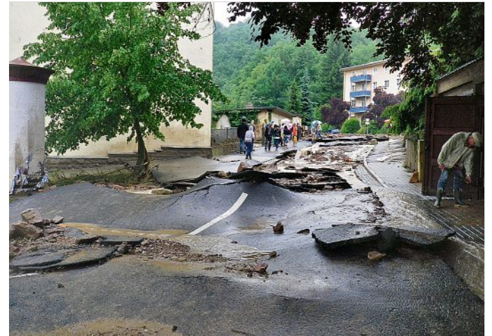
Der zerstörte Straßenbelag am Kirchsteig.
