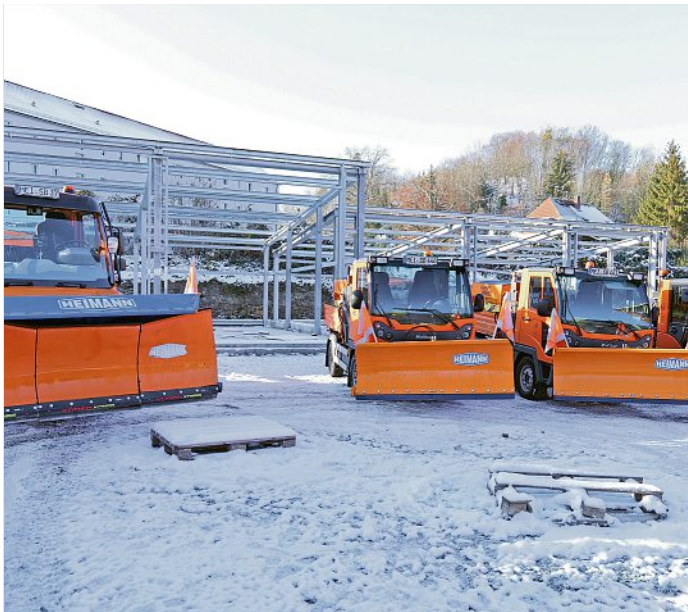
Winterdienstfahrzeuge vor dem Rohbau der künftigen Fahrzeughalle.
