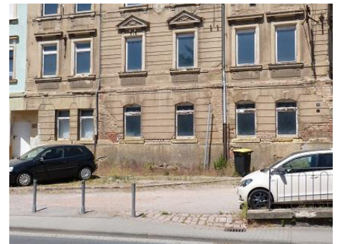
Abbildung 4 unsanierte Gebäude im Gebiet (Mühlweg 1, Rosa-Luxemburg-Straße 21-23)
