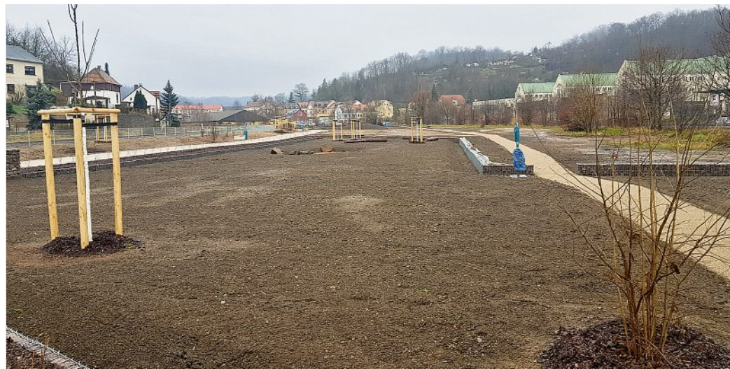
Der erste Bauabschnitt im Areal Bürgergarten Triebischtal ist fast abgeschlossen.
