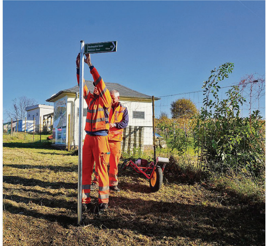
Die Mitarbeiter des Bauhofs befestigen die neue Wanderauschilderung.
