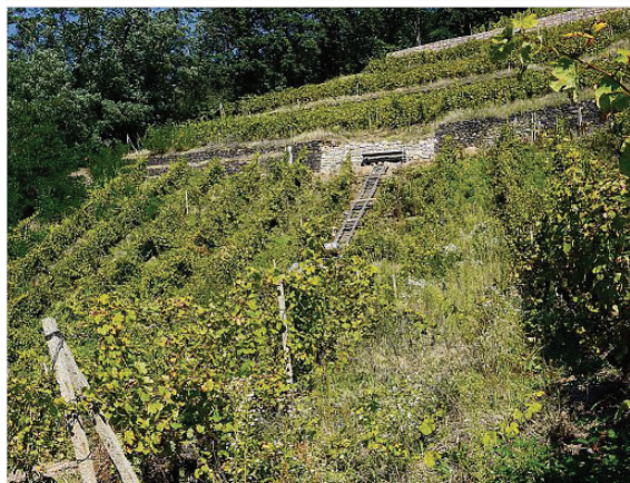
Sanierung einer historischen Stützmauer in Meißen Spaar.
