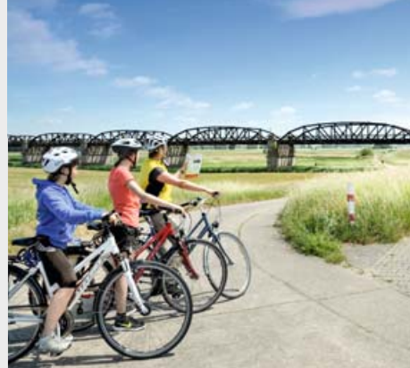
Blick zur alten Eisenbahnbrücke bei Dömitz
