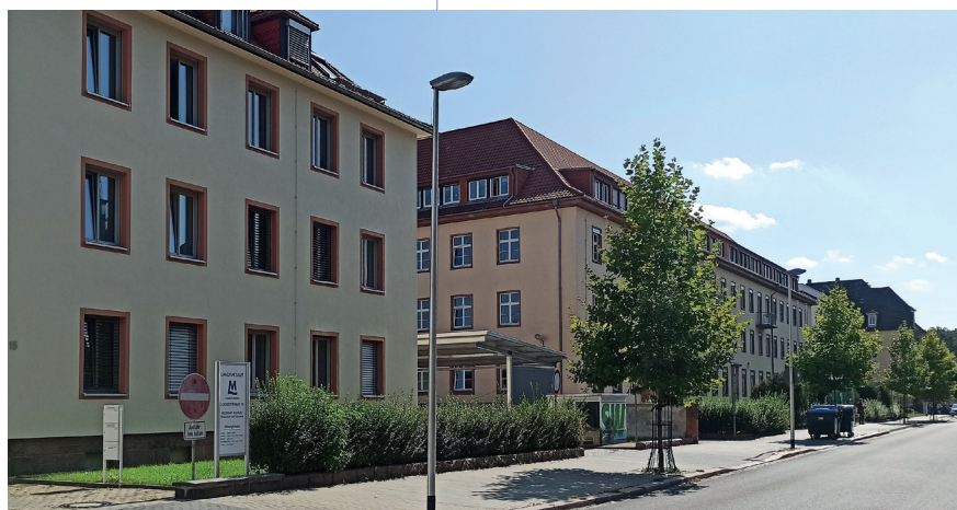
Der Gebäudekomplex aus den 1930er Jahren wurde umfassend saniert und ausgebaut.
