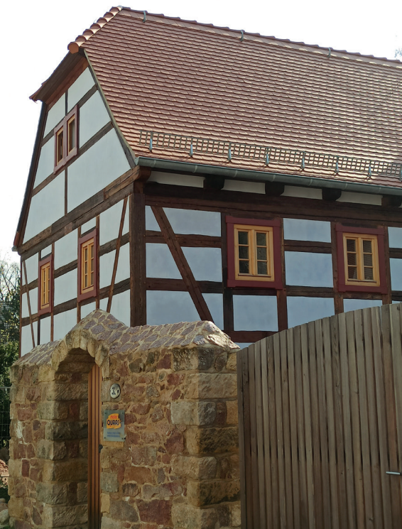
Die detailgetreu sanierte Fachwerkfassade am Lutherplatz 3.
