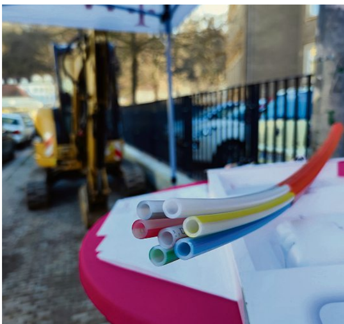
Sind in Meißen bald überall Standard: Glasfaserkabel für schnelle Datenübertragung.
