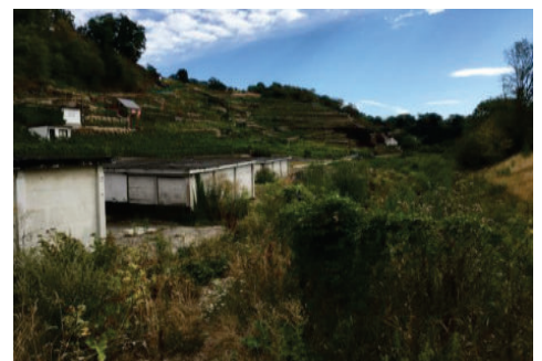
Eingangssituation am Fürstengraben mit Garagenhof
