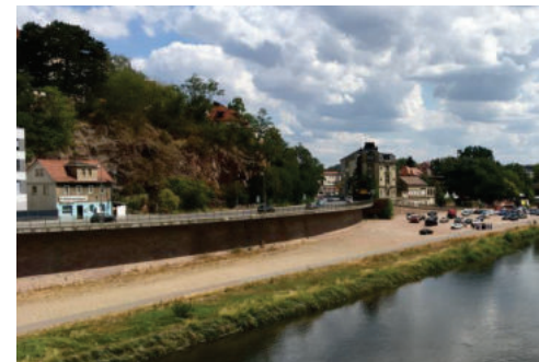
Blick von der Altstadtbrücke in die Bahnhofstraße mit desolater Bausubstanz, Parkplätze an der Elbe
