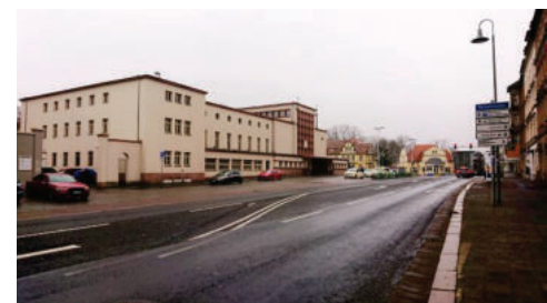
Bahnhof Meißen mit Bahnhofsvorplatz an der Großenhainer Straße
