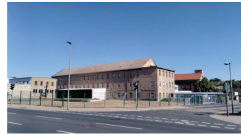
Industriebauung an der Zscheilaer Straße
