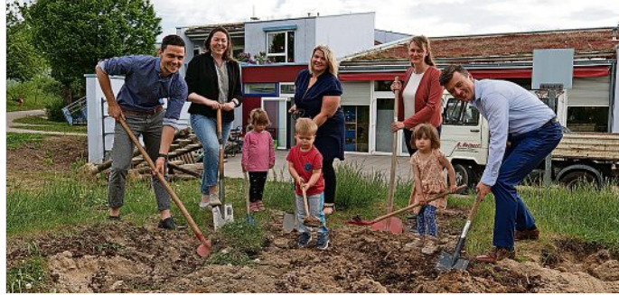
Gemeinsam mit Bürgermeister Markus Renner, Vertretern der Kita und des Fördervereins konnten die ersten Spatenstiche erfolgen.
