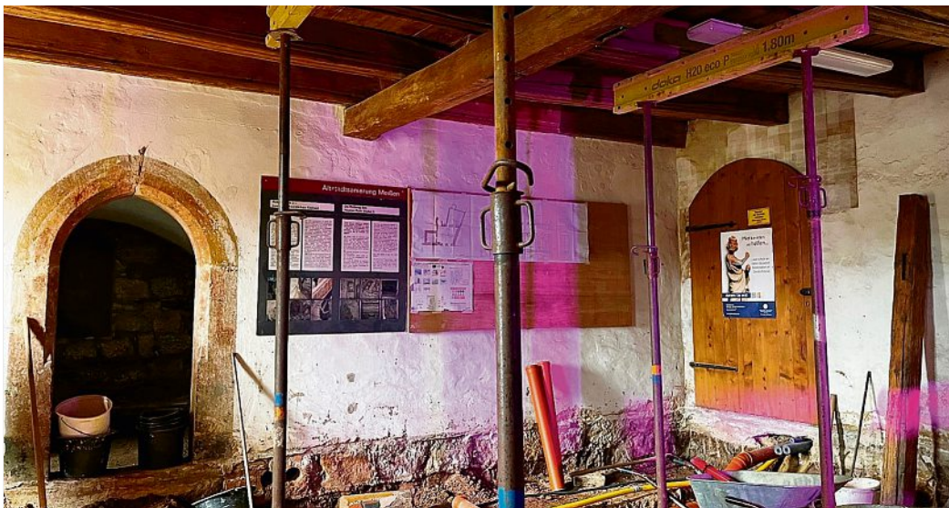
Statische Sanierung der Holzdeckenbalken
