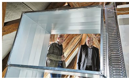
In den Stahlboxen im Dachgeschoss wird die neue Haustechnik untergebracht. Foto: Stadt Meißen
